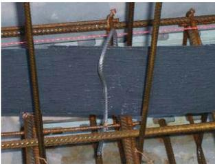
**Placer** le couvre-joint métallique CEMflex VB avec le revêtement sur les deux faces au centre du joint et le fixer (avec un étrier de fixation CEMflex  $\Omega$ ).
